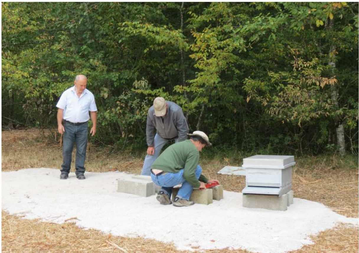
La préparation du terrain et le calage des supports
