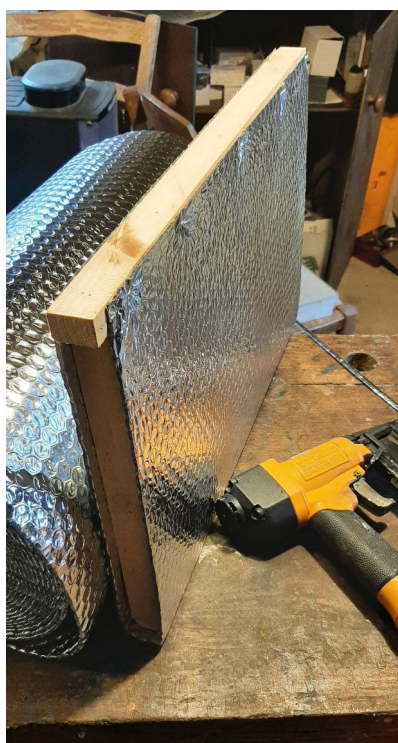
Partition chaude terminée.
