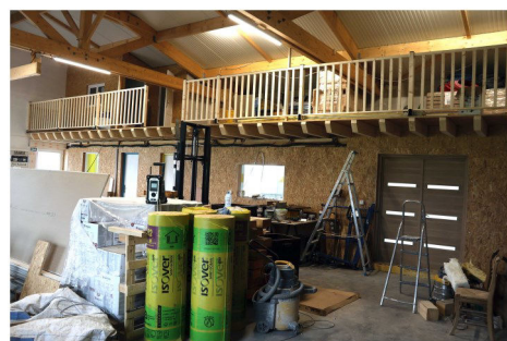
La mezzanine avec la chambre privative pour le stagiaire, et la vitre de devanture en bas avec vue sur la salle d'extraction.
